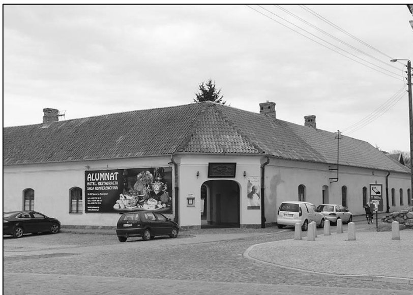
2. Alumnat od strony wjazdu w południowo-zachodnim narożniku budynku, fot. autor
